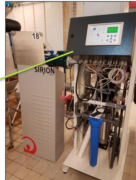
Membrananlægget set forfra
